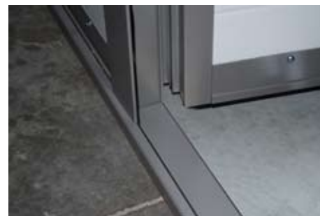
faible hauteur de seuil
