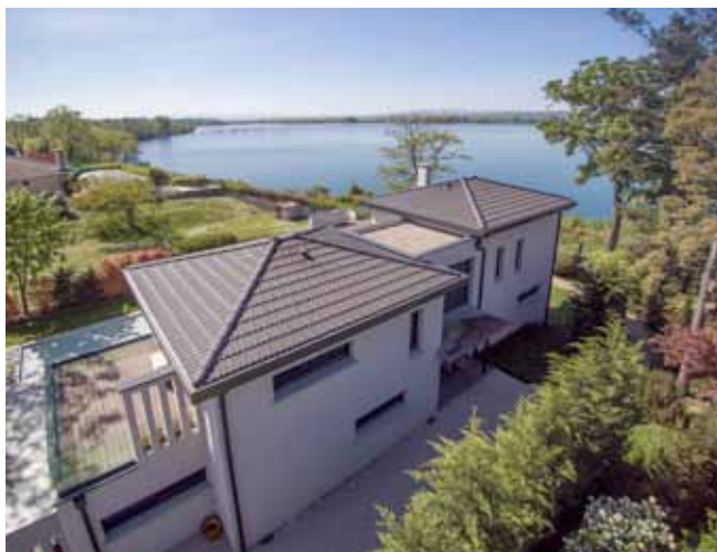
IMERYS Toiture RHÔNA 10 coloris Ardoisé. Mise en œuvre Sélection Artisanale. Crédit photo Loïc Lagneau
