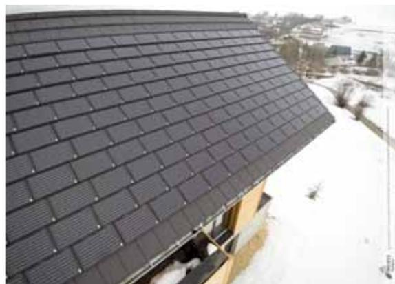
Performants, les 26 kits Alpha Solaire qui équipent la maison produisent entre 8,3 et 8,7 kWc/an, soit un niveau de rendement au m<sup>2</sup> équivalent voire supérieur (159 Wc) à celui des panneaux standards (155 Wc).
