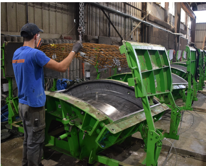
Mise en place de l'armature
