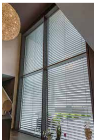
Brise-soleil orientables avec un tablier en coloris Aluminium Blanc (RAL 9006), encadrement du coffre, coulisses et barre de charge en gris anthracite. Motorisation radio Somfy IO
