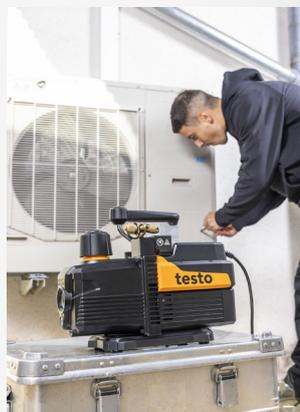
Le tirage au vide est une étape importante pour garantir la performance et la durabilité d'un système frigorifique ou de climatisation, que ce soit lors de la mise en service ou du remplacement d'un élément du circuit.
