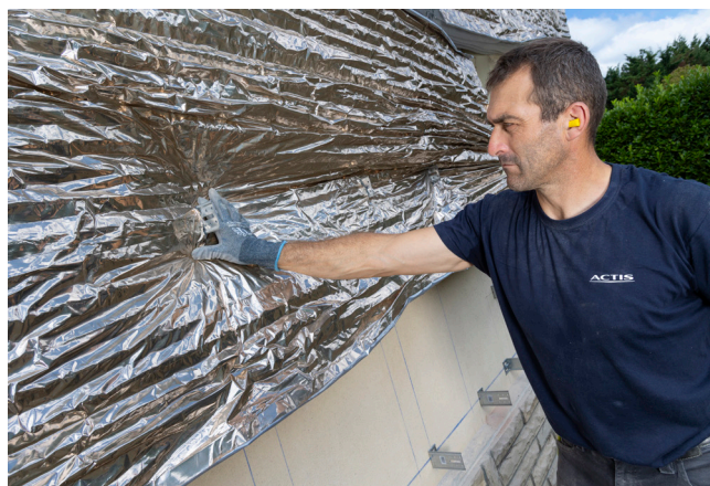
1 - Pose des pattes-équerrres et mise en place des panneaux isolants en réalisant les jonctions
