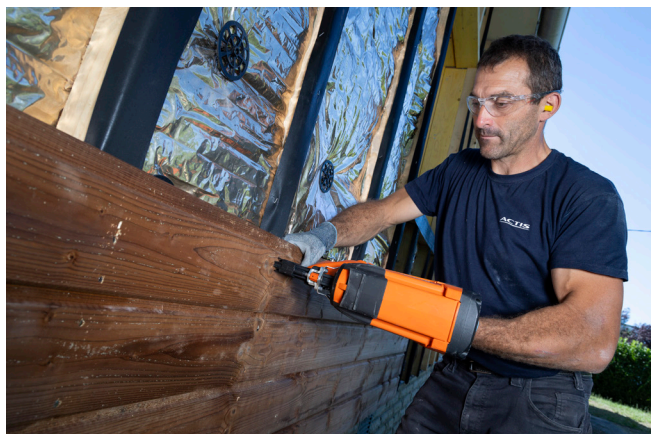
4 - Mise en place du bardage
