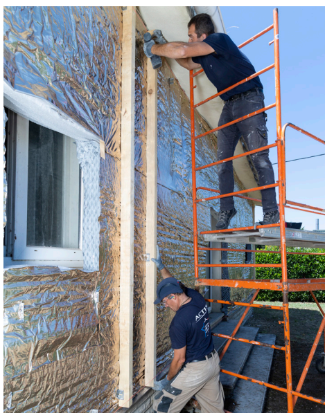
2 - Fixation des montants bois supports de bardage
