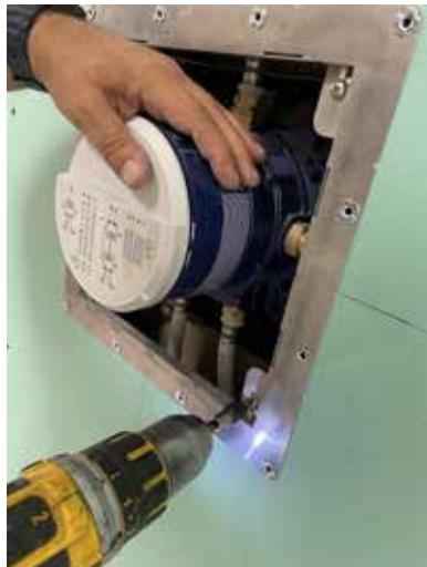
Le plombier pourra, s'il souhaite effectuer cette opération, utiliser la toile de verre de 36 x 36 cm incluse dans le kit et appliquer ensuite un système d'étanchéité liquide (SPEC) autour du ROBIBOX®. L'ensemble sera alors recouvert par du carrelage dans l'espace douche pour qu'il devienne totalement invisible. Un gain de temps de 50% est ainsi obtenu par rapport à un encastrement traditionnel !
