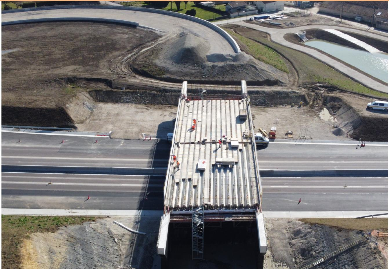
A hauteur de Ligny-en-Barrois dans la Meuse, l'échangeur de la RN4 - RN135 destiné à contourner la commune de Velaines a nécessité la construction d'un ouvrage d'art. Le mandataire de ces travaux, NGE GENIE CIVIL, a fait appel à l'expertise de Capremib, spécialiste reconnu de la préfabrication béton sur-mesure pour les marchés du bâtiment et du génie civil, pour réaliser ce pont constitué de poutres précontraintes.
