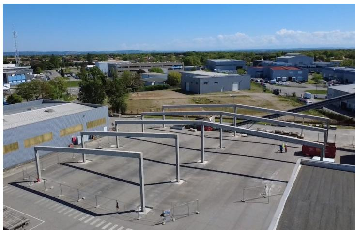
Pour s'adapter aux contraintes des parcs industriels ou logistiques (stockage de marchandises, parking d'engins de chantier, de véhicules utilitaires,...), les ombrières de Rector sont dotées d'ossatures en béton sans bracon, à grandes portées ( $>15$  m) et grandes hauteurs (jusqu'à 15 m), avec des fondations réduites pour optimiser les coûts et l'implantation. Elles sont conçues pour offrir une structure à la fois robuste, durable et à faible empreinte carbone.
