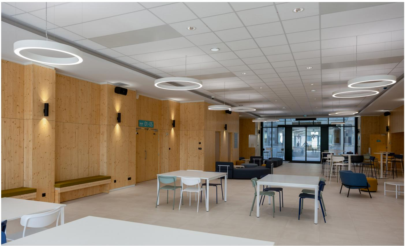
Intégrés parfaitement en faux-plafond, les panneaux Zehnder Carboline sont composés d'un bac métallique et d'un échangeur thermique en graphite expansé, matériau à la conductivité très élevée qui permet au système de réagir très rapidement aux variations de température d'alimentation, en chauffage comme en rafraîchissement.
