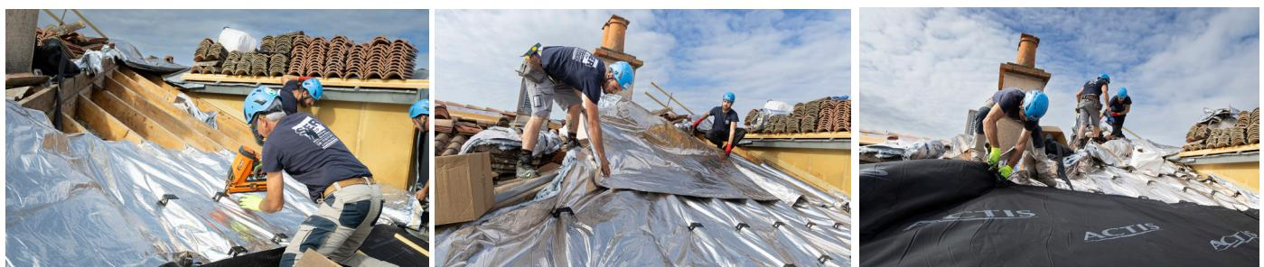
Installé par l'extérieur, sans rehausse importante de la toiture et sans modification de l'aspect du bâti, l'isolant alvéolaire réflecteur Triso-Toiture d'Actis se compose de deux isolants complémentaires mis en œuvre de manière à former une enveloppe isolante et étanche :
