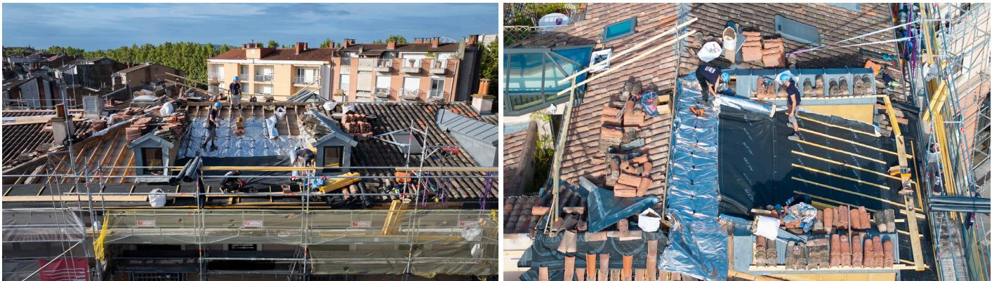
« L'intérêt d'utiliser du Triso-Toiture était de rester dans l'épaisseur du chevron et de ne pas empiéter sur la surface habitable des appartements situés sous les combles et d'engendrer des travaux supplémentaires sur les plafonds mais aussi l'électricité, la plomberie.... » explique Olivier Devalland, chef de Chantier SERBTP.
